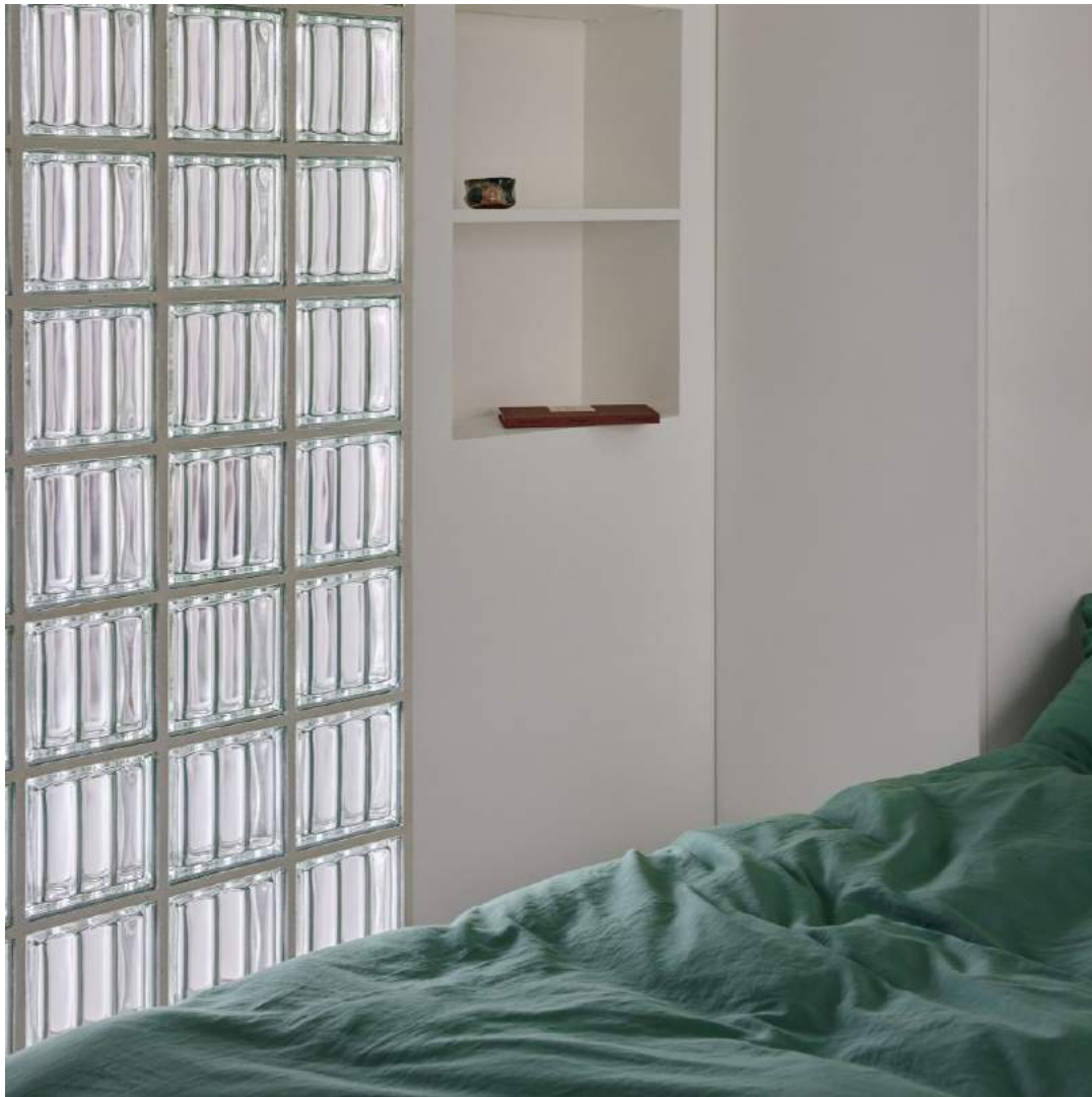
Cloison en briques 19*19 cm modèle Dorique. Architecture et design Alors Studio, photographie Anne-Sophie Soudoplatoff
